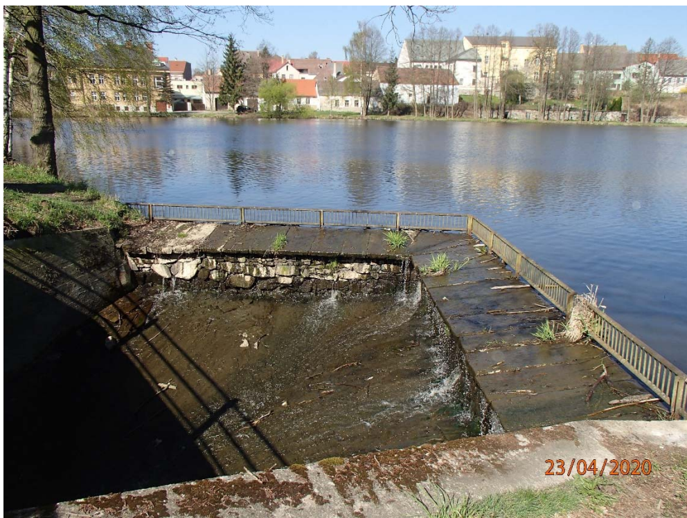
Rybník Tovární. Pohled na bezpečnostní přeliv – havarijní stav.
